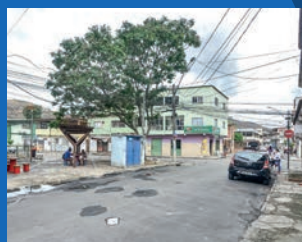
04. Asfaltamento da rua Ministro Rui Barbosa - Santo André
