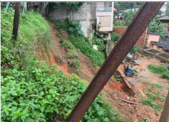
Esc. Alcides Santos, próximo ao nº, 75, Forte São João – 29/11/22
