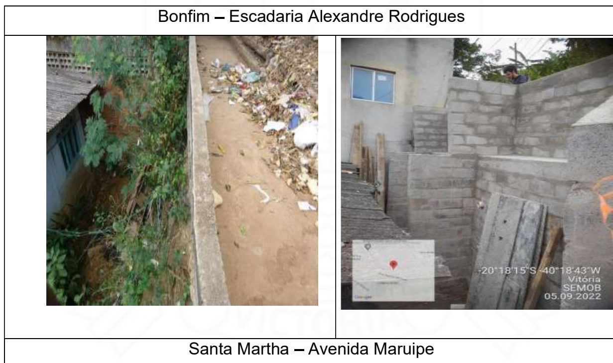
Figura 9 - Antes e depois de algumas obras de 2022
