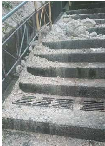
Beco Rives Borges Barcelos, próximo ao número 23 e av. Vitória - Forte São João – 29/11/22
